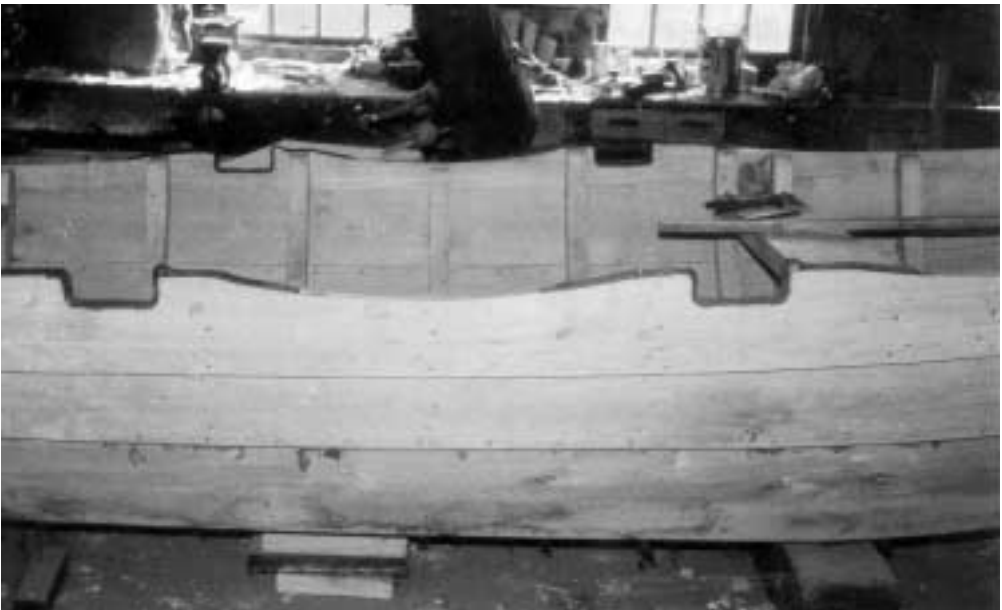
Figuur 4.7 Het boeisel is aangebracht en in de dollen is een ijzerbeslag aangebracht.
