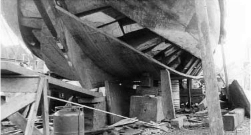
Figuur 6.3 Restauratie aan de botter MK 63; vlak, kielbalk en kimgangen worden vernieuwd. (foto: P. Dorleijn)
